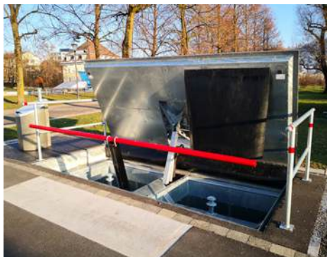
SW 400, mit Elektro-Hydraulik und Abstützgeländer.
