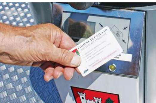
Der Einwurf kann nur mittels Access-Card geöffnet werden.
