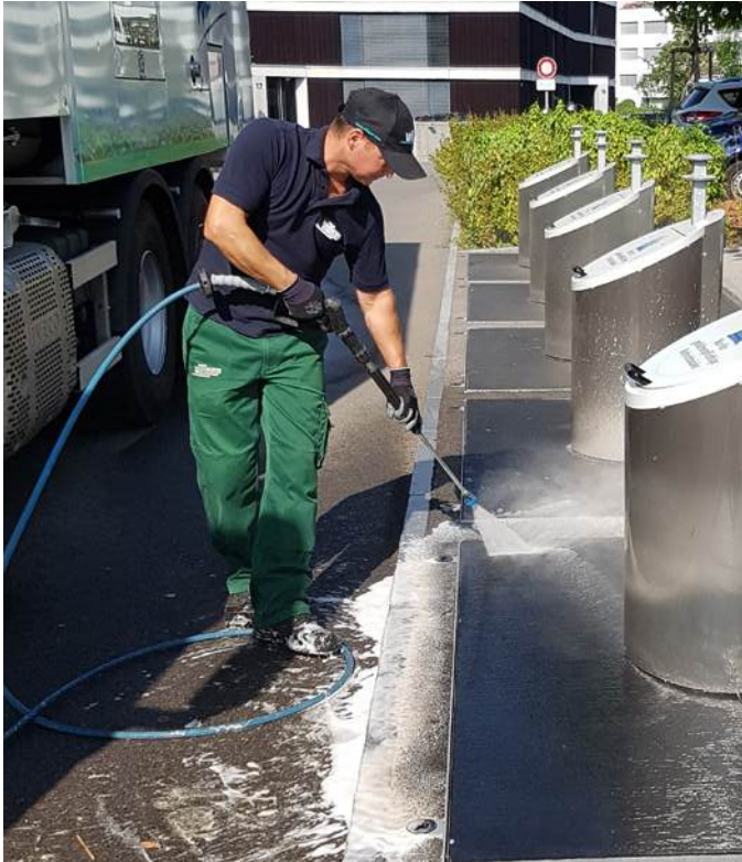
Mit Hochdruck- und Vorsprühreinigern werden sämtliche Restverschmutzungen entfernt.
