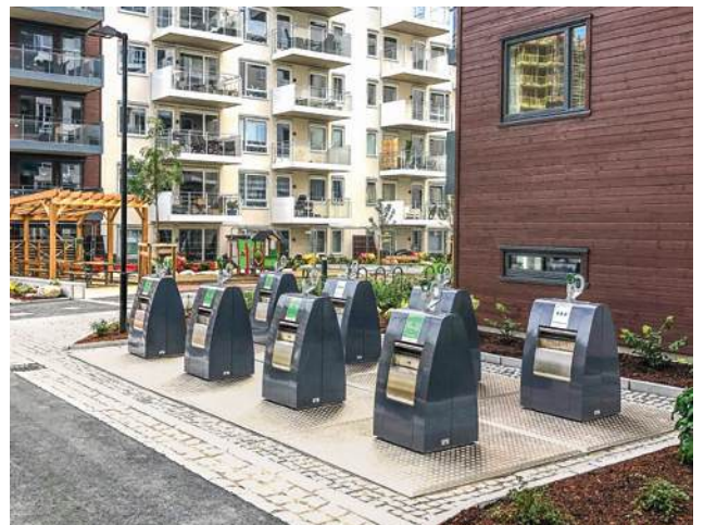
Sub-Vil Lugano mit elektronischer Zutritts- und Füllstandsüberwachung in Oslo (NO).
