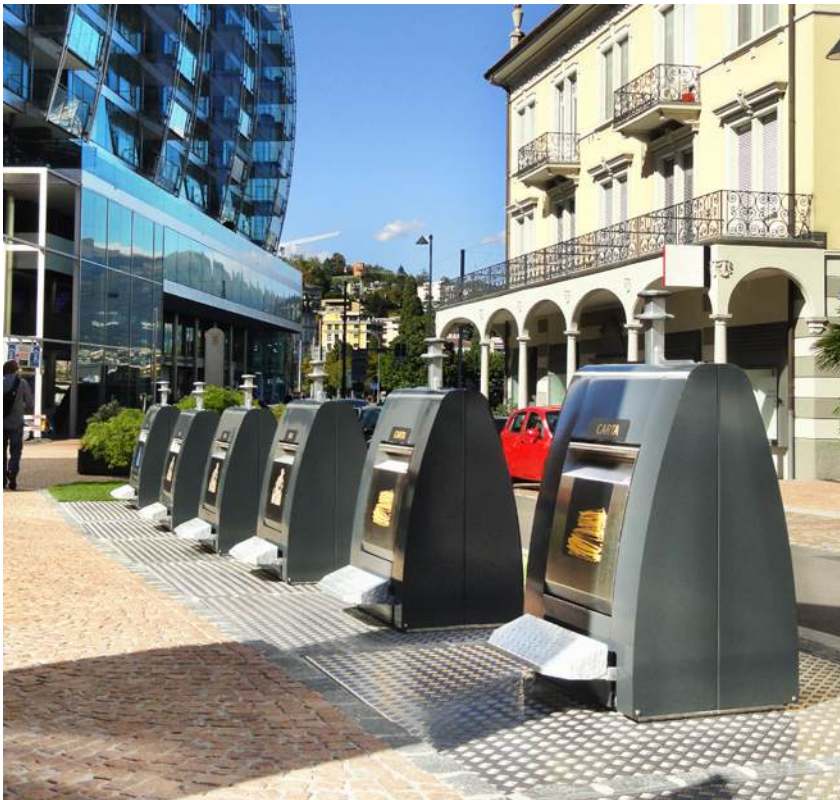
Nach dem Umbau mit Villiger-System
