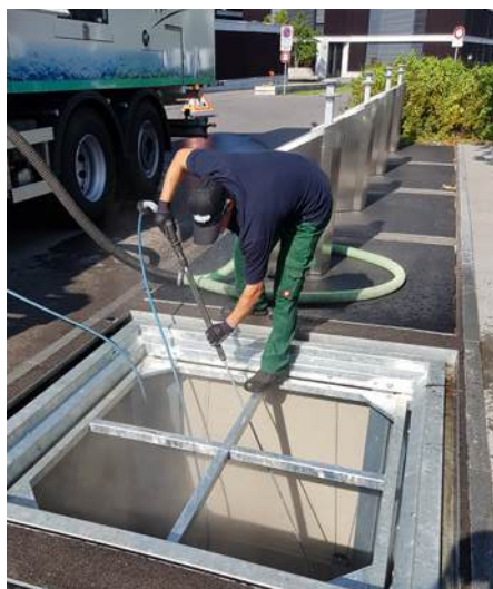
Beton-Innenreinigung mit Hochdruckreiniger.
