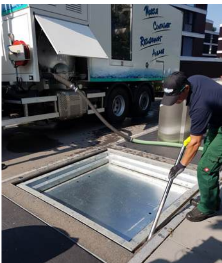
Absaugen von Restverschmutzungen wie Wasser und Laub.
