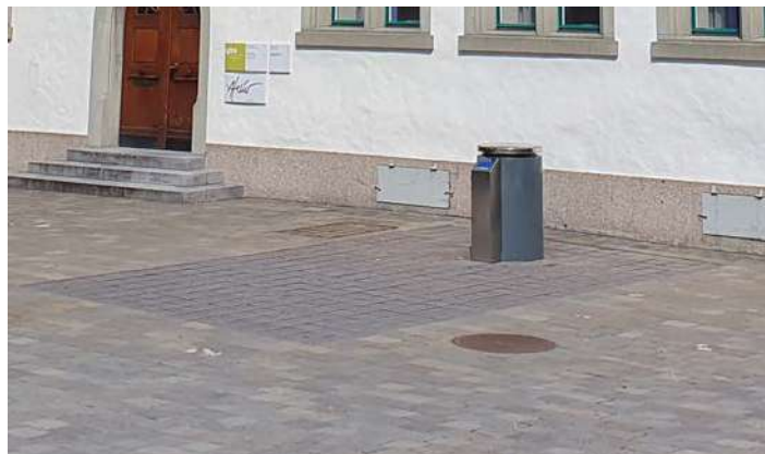
Einwurfsäule rückseitig vom Liftsystem. Für eine Container-Entleerung muss jeweils der Presscontainer gewendet werden.
