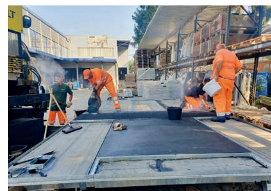
Aufbringen eines Gussasphalts.
