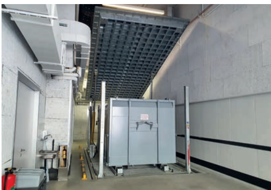
Hochgefahrener Lift für das Bela- den des Press- containers.
