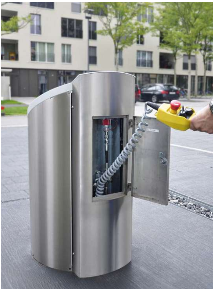
Elektrische Betätigung mit Bedienungseinheit in der Rückseite der Einwurfsäule, inkl. Not-Hydraulik-Anschluss.
