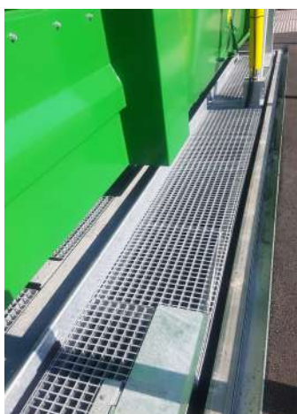
Einführschiene für die Platzierung vom Presscontainer.
