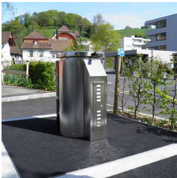
Caslano mit integrierter Lüftung
