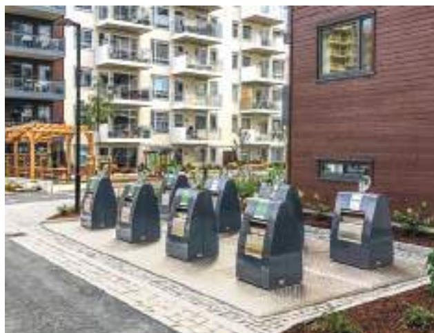
Sub-Vil Lugano avec surveillance électronique d'accès et de niveau de remplissage à Oslo (NO).
