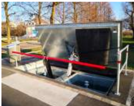
SW 400, avec système électro-hydraulique et garde-corps.
