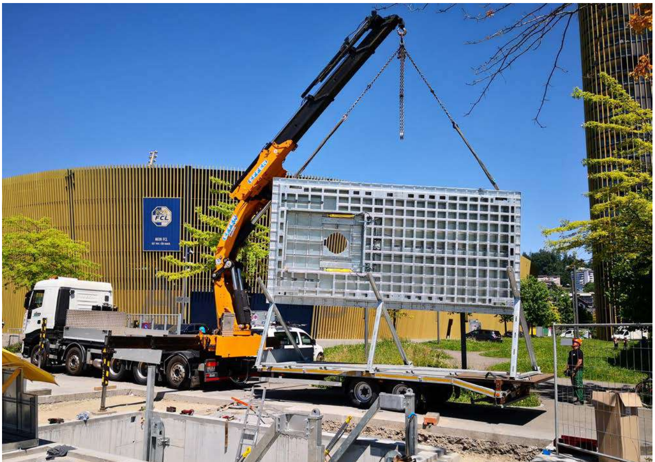
Transport d'une plate-forme et travaux d'installation correspondants.
