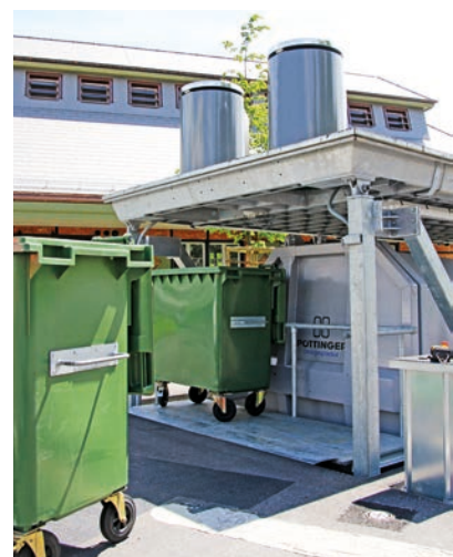
Retrait du conteneur sur roues depuis la plateforme. Avec capteur de niveau de remplissage intégré.
