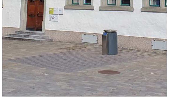
Colonne d'insertion à l'arrière du système de levage. Pour être vidé, le conteneur compacteur doit être retourné.
