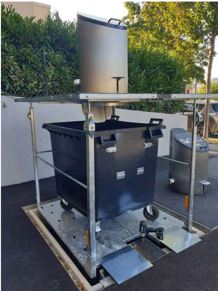
LU 150-L con colonna Baléro 120 sollevata per la rimozione del contenitore.
