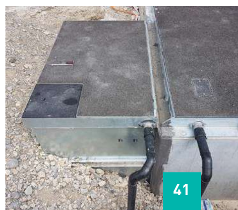
Tubi di drenaggio, albero tecnico e piattaforma
