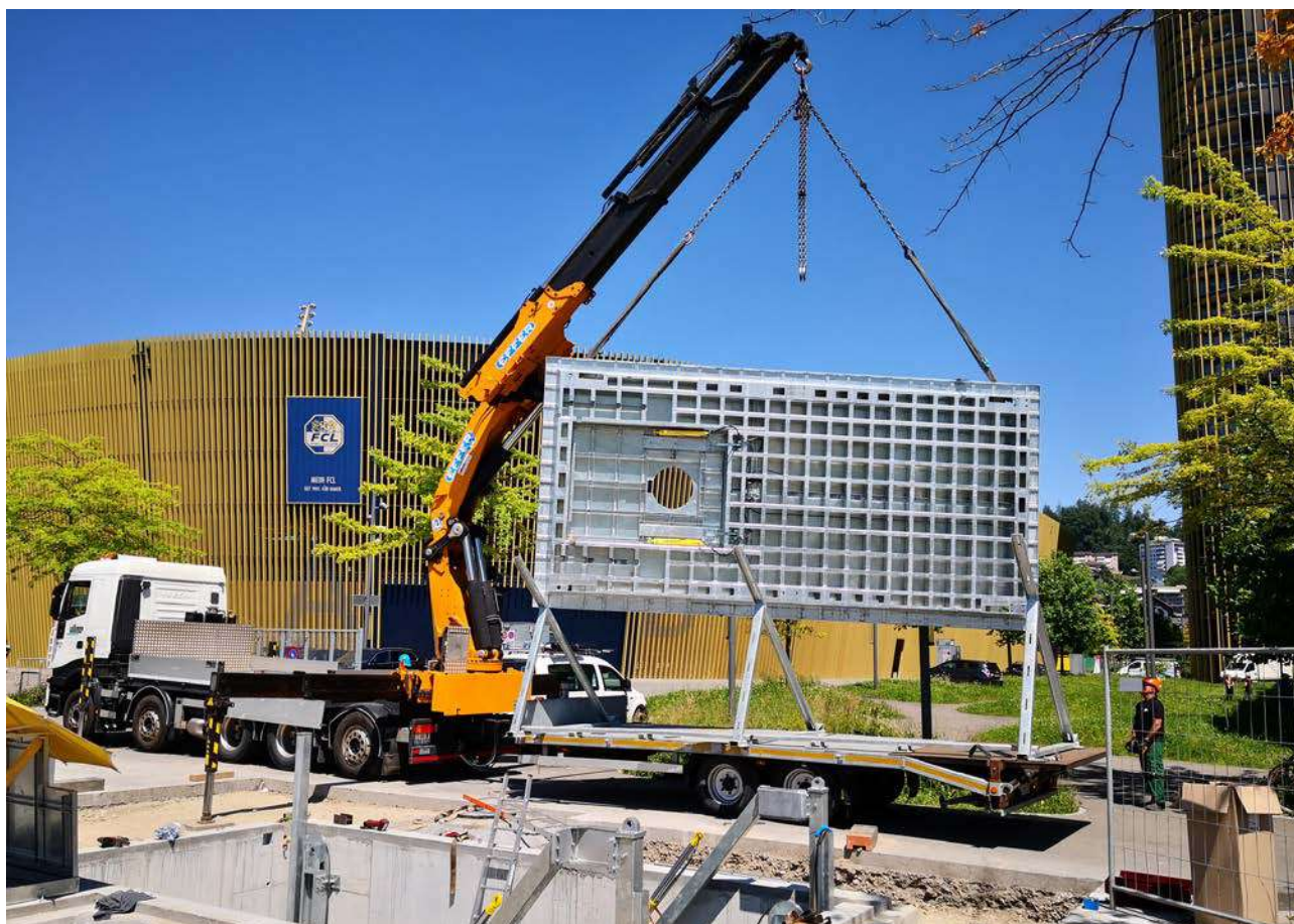
Trasporto di una piattaforma e lavori di installazione associati.
