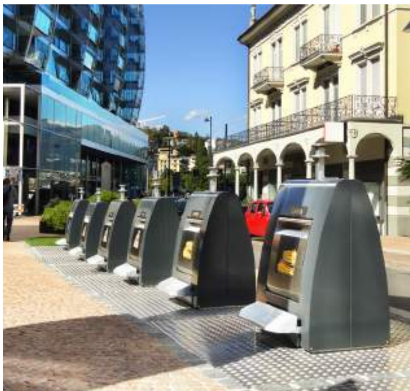
Dopo la trasformazione con sistema Villiger
