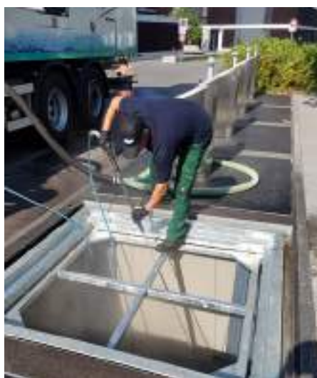
Lavaggio interno del calcestruzzo con idropulitrice ad alta pressione.
