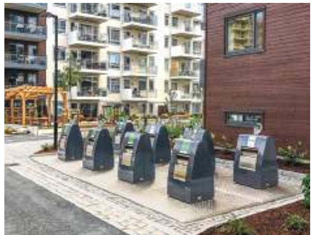
Sub-Vil Lugano con monitoraggio elettronico dell'accesso e del riempimento a Oslo (Norvegia).
