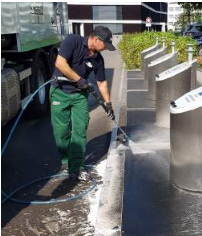
Tutto lo sporco residuo viene rimosso con idropulitrici ad alta pressione e detergenti per spruzzatura preliminare.
