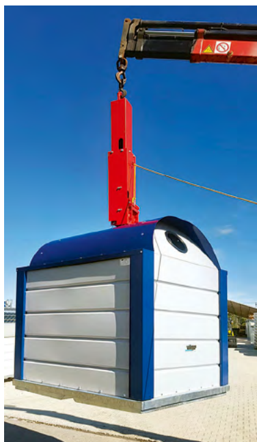
Levage avec un fond de conteneur sécurisé et fermé.
