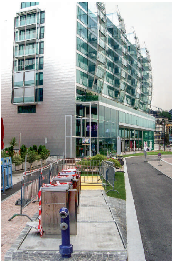
Vor dem Umbau ...
