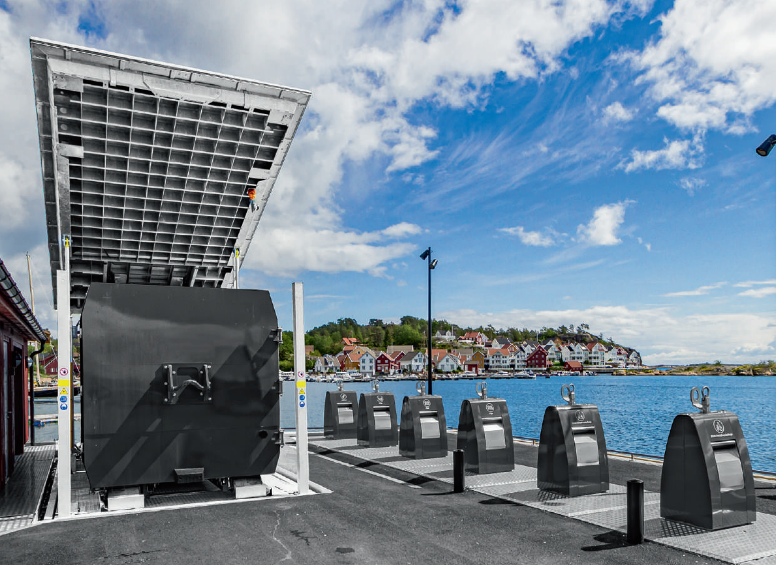
In dem unterirdisch platzierten Presscontainer an der Küste Norwegens werden bis zu 20 m 3 verdichteter Abfall gesammelt. Die Entsorgungskosten konnten damit signifikant reduziert werden.
