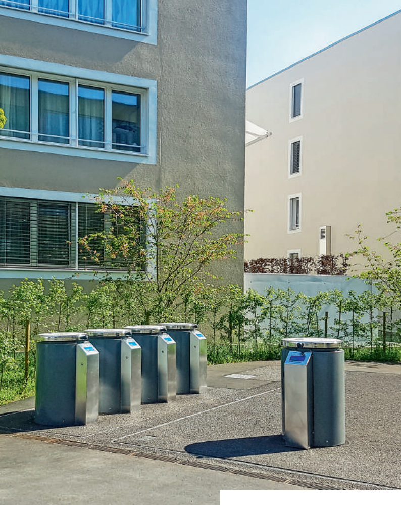
Liftomat Anlage LU 500 mit vier 770 l Rollcontainer für Bioabfall.
