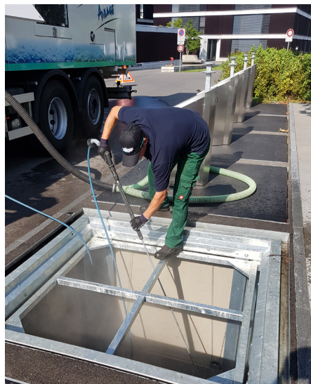
Beton-Innenreinigung mit Hochdruckreinigung.
