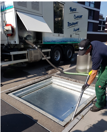
Absaugen von Restverschmutzungen wie Wasser und Laub.
