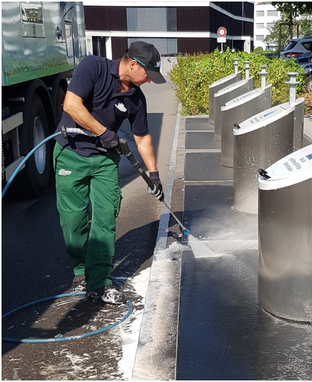
Mit Hochdruck- und Vorsprühereinigern werden sämtliche Restverschmutzungen entfernt.
