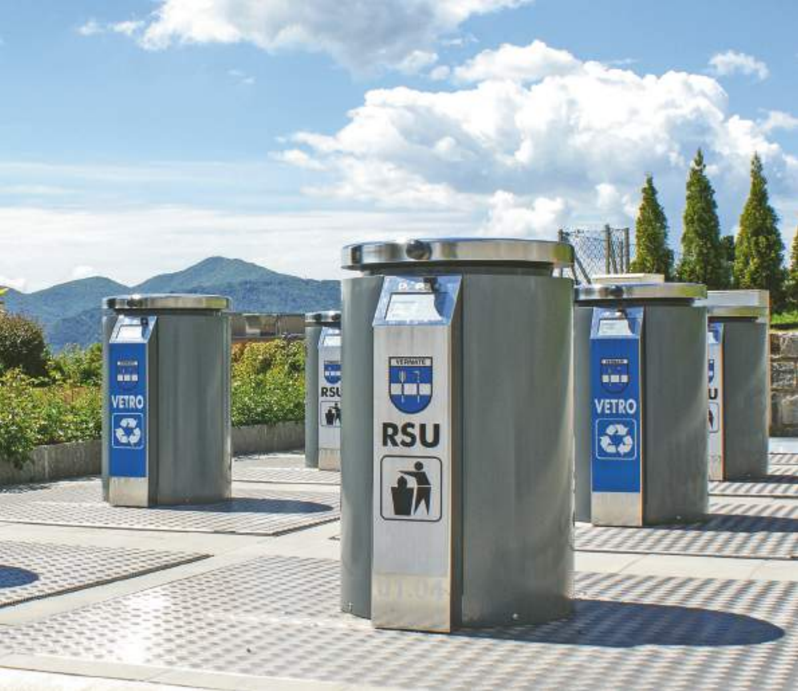
Point de collecte avec colonnes d'insertion Caslano et accès électronique avec pesage.
