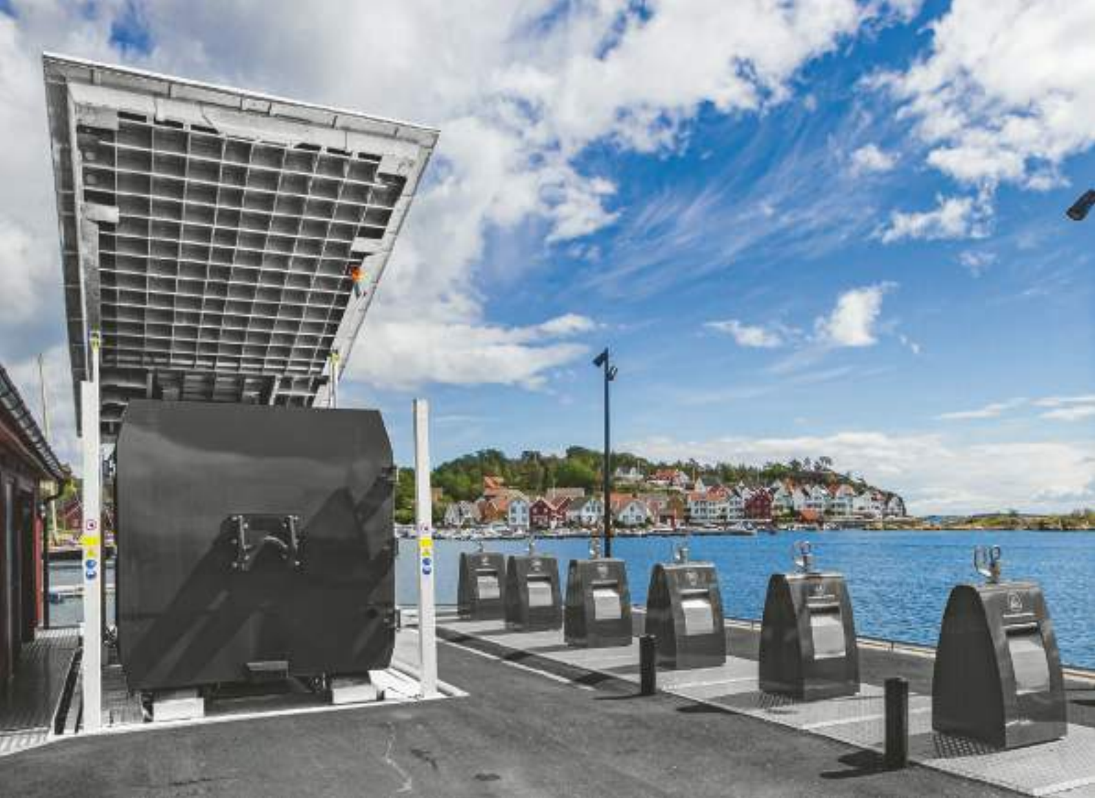
Le conteneur compacté placé sous terre sur la côte norvégienne permet de collecter jusqu'à 20 m 3 de déchets compactés. Les coûts d'élimination ont ainsi pu être réduits de manière significative.
