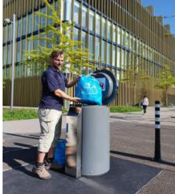
Système d'accès avec largage de sacs-poubelle
