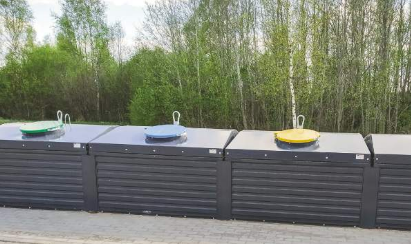
Semi-souterrain Semi-Sub avec habillage en tôle trapézoïdale.
