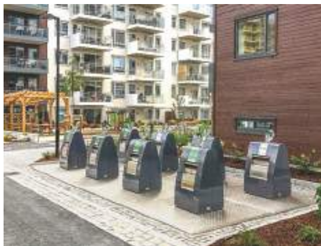
Sub-Vil Lugano avec surveillance électronique d'accès et de niveau de remplissage.
